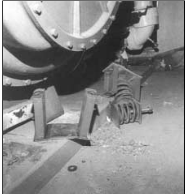
Şekil 13.4 / SİSMİK SINIRLAYICISIZ BAĞLANTI
