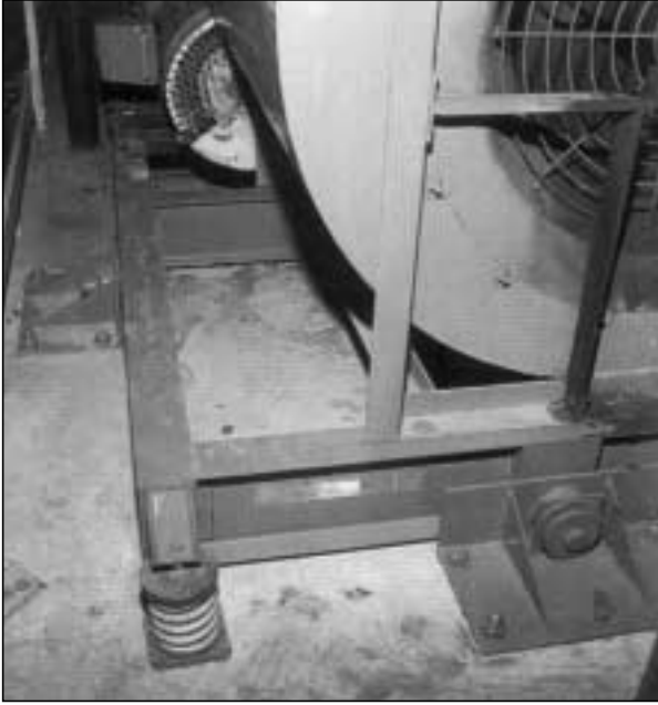
Şekil 13.5/ SİSMİK SINIRLAYICI CİHAZI KORUR
