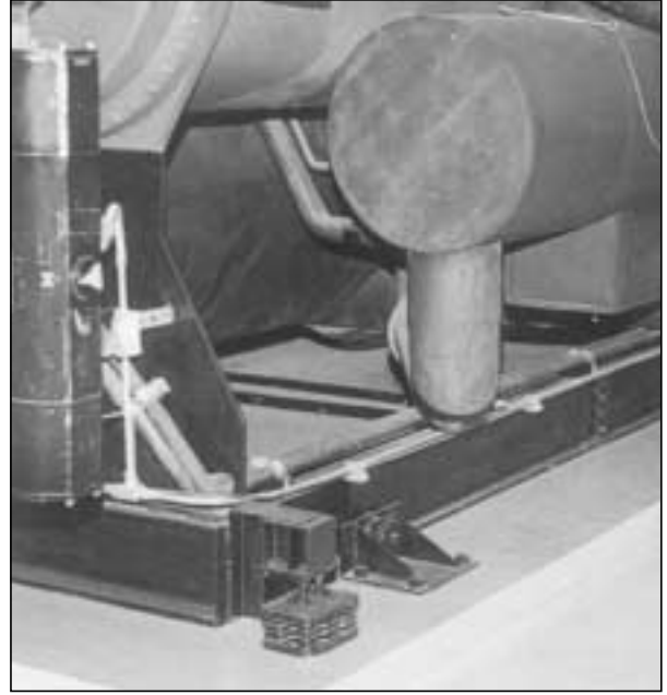
Şekil 13.6/ SİSMİK SINIRLAYICI HALİNDE ZARAR YOK
