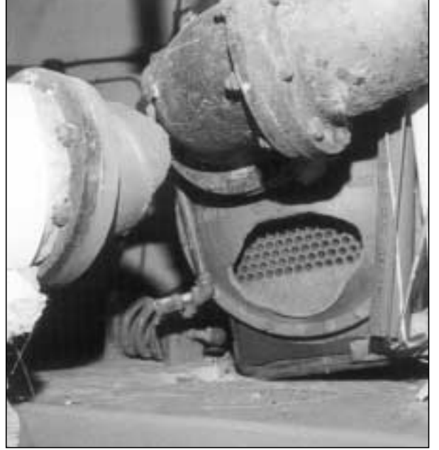
Şekil 13.3 / SİSMİK SINIRLAYICISIZ BAĞLANTI
